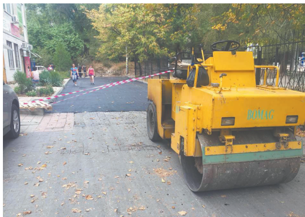
Ремонт дороги вокруг ТЦ рядом со сквером «Семицветик»
